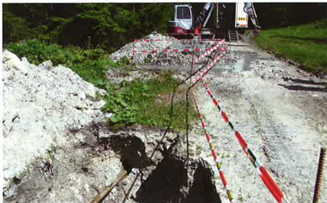
Bohrgrube bei der Geigenquelle: links vorne das Bohrgestänge.
